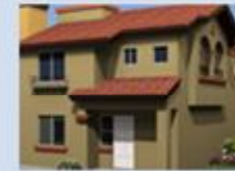
Casa Real Plus. Desde 122m2 (con terreno excedente)
